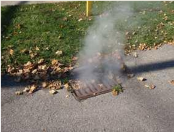
Typický kouřící kanál
